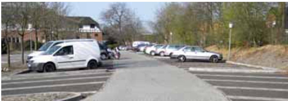
Neuanlage: Der Parkplatz auf dem alten Platzteil
